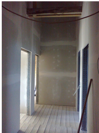
Trockenbau im DG
